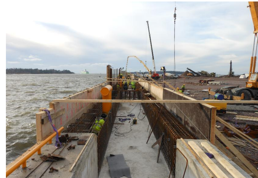
Kuva: Reunapalkkityömaa v. 2012 Eteläkärjen edellisessä laiturilaajennuksessa
