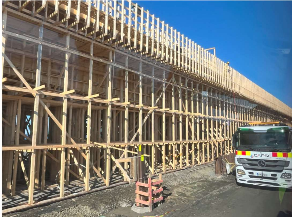
Hailuodon Riutun siltatyömaa toukokuu 2025, 737 m © Eero Nippala
